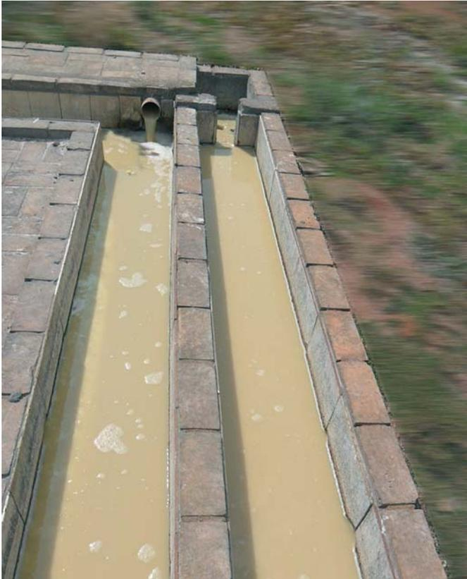
Coletada no interior da fábrica, a manipueira segue por tubulações e calhas até chegar a um tanque. Após análises de brix e pH, é iniciado o processo de hidrólise que culminará na produção de álcool
